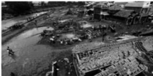
Gambar 3. Kondisi rumah warga yang rusak berat dan sebagian hanyut diterjang banjir bandang di tepi Sungai Cimanuk. ( http://regional.kompas.com/read/2016/10/26/19584561/pasca-banjir.bandanggarut.butuh.rp.626.3.miliar.untuk.pemulihan ).
